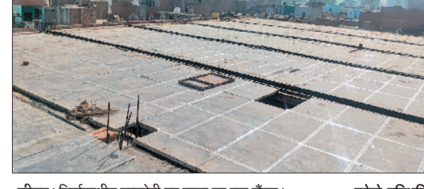
सीवन। निर्माणाधीन लाइब्रेरी पर डाला जा रहा लैंटर। फोटो: हरिभूमि
